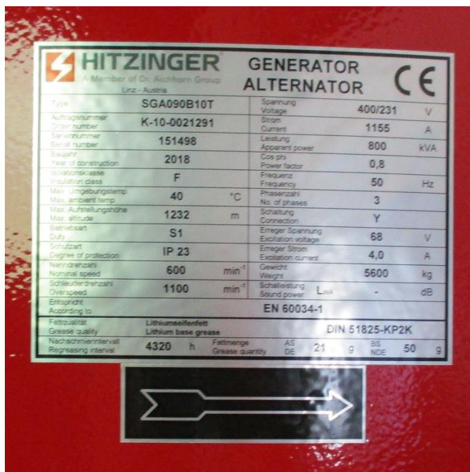
Abbildung 5: Typenschild des Generators
