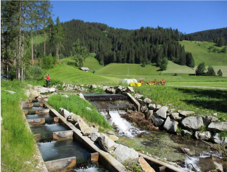
Abbildung 1: Wasserfassung und Fischpass
