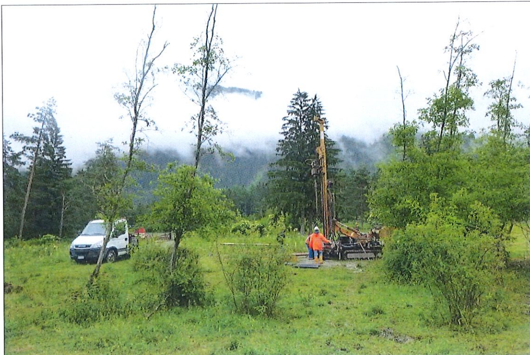
PIAZZAMENTO PERFORATRICE SUL PUNTO DI SONDAGGIO S3-18
