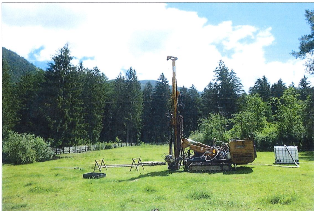
PIAZZAMENTO PERFORATRICE SUL PUNTO DI SONDAGGIO S2
