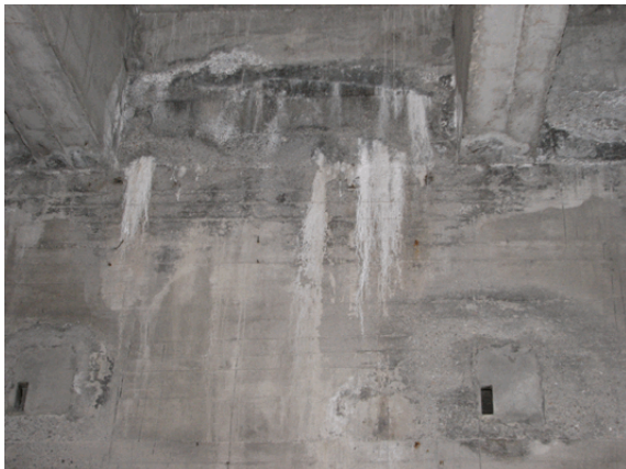
Foto 1: in ampie zone sulla spalla di monte, soprattutto in sommità e a sinistra, sono presenti macchie d'umidità.
