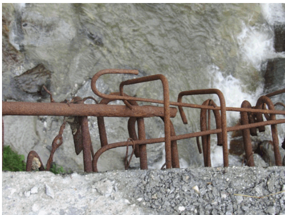
Foto 54: particolare dall'alto della porzione di soletta poste sul lato sinistro completamente mancanti di cui rimangono unicamente le armature.
