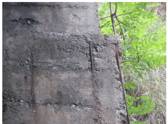
Foto 15: sulla spalla di valle ove presente il distacco del copriferro si rilevano armature corrose con sezione resistente intaccata.
