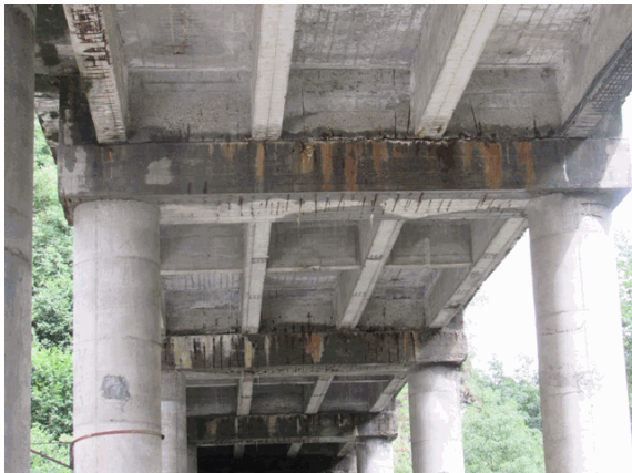
Foto 25: ovunque sui pulvini delle pile si rilevano macchie di umidità.
