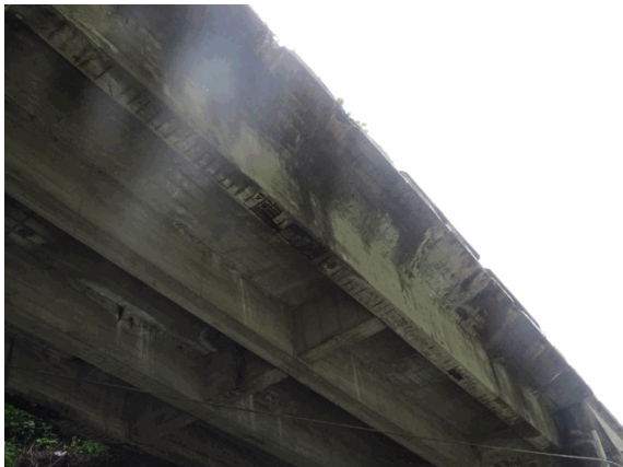
Foto 33: in ampie zone sulle travi, in particolare su quelle di bordo di tutte le campate e in corrispondenza degli appoggi su spalle e pile si notano macchie di umidità.
