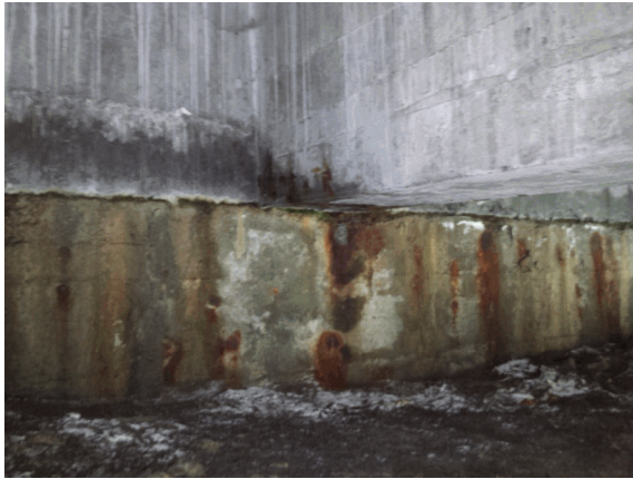
Foto 12: ovunque sulla spalla di valle si rilevano macchie di umidità.
