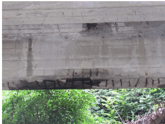
Foto 34: in diverse zone sulle travi in particolare quelle di bordo e agli appoggi su spalle e pile si nota il dilavamento del calcestruzzo.
