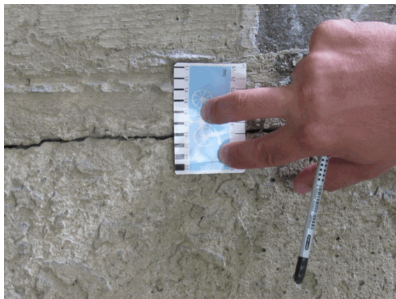
Foto 8: particolare della fessura orizzontale presente sulla spalla di monte con ampiezza massima pari a 2,5 mm.
