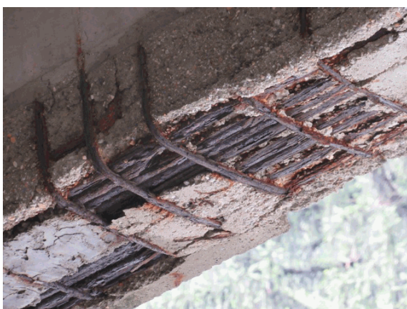
Foto 37: sulle travi, in particolare quelle di bordo ove presente il distacco del copriferro si rilevano armature corrose e ridotte di sezione.
