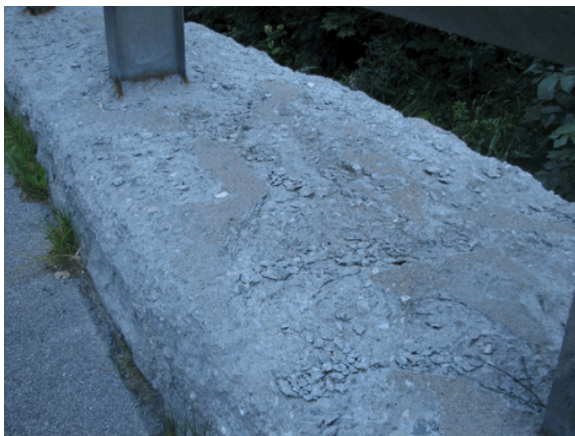
Foto 58: entrambi i cordoli risultano fortemente degradati.
