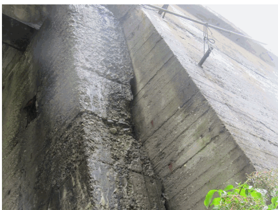
Foto 3: in alcuni punti della spalla di monte, in particolare alla base e sullo spigolo di sinistra il calcestruzzo risulta ammalorato.
