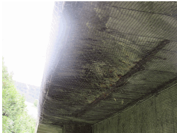
Foto 49: sulle facciate laterali e lungo una fascia all'intradosso degli sbalzi laterali della soletta si riscontra il dilavamento del calcestruzzo.
