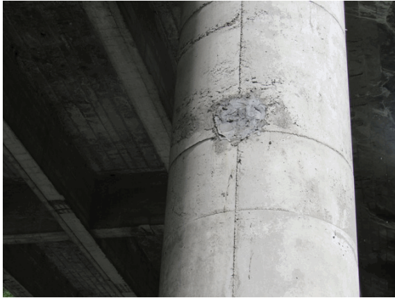
Foto 23: in rare zone verso la sommità dei pilastri si rilevano riprese successive deteriorate.
