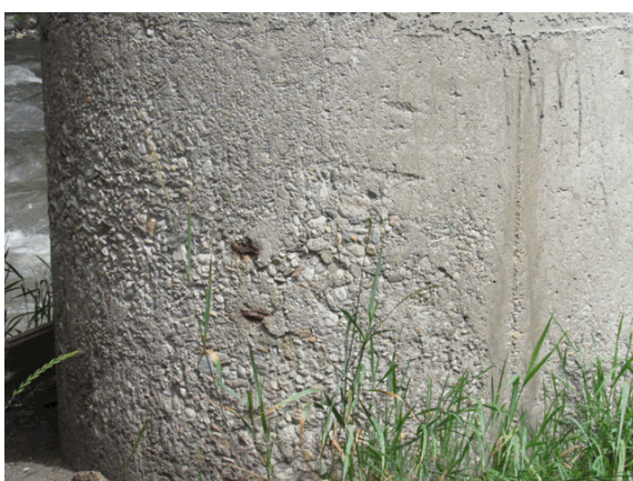
Foto 19: in alcuni punti su tutti i pilastri sono presenti dei vespai con inerte in vista.
