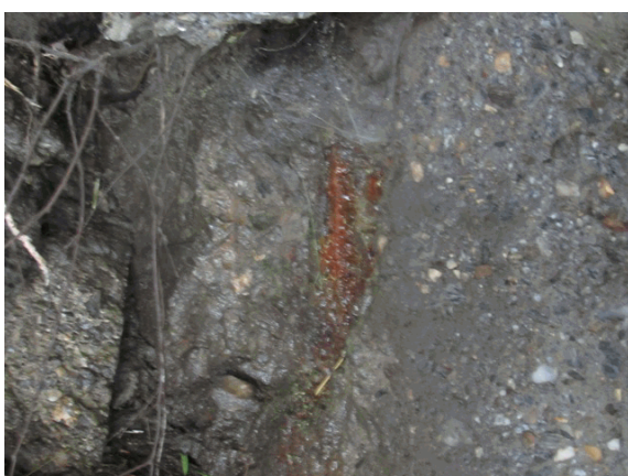
Foto 5: in rare zone sulla spalla di monte in particolare in un punto in sommità verso lo spigolo destro il copriferro risulta distaccato.
