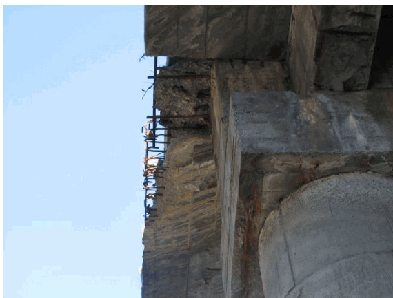
Foto 52: particolare di una zona tra la III e IV campata ove si notano grandi porzioni mancanti di calcestruzzo.
