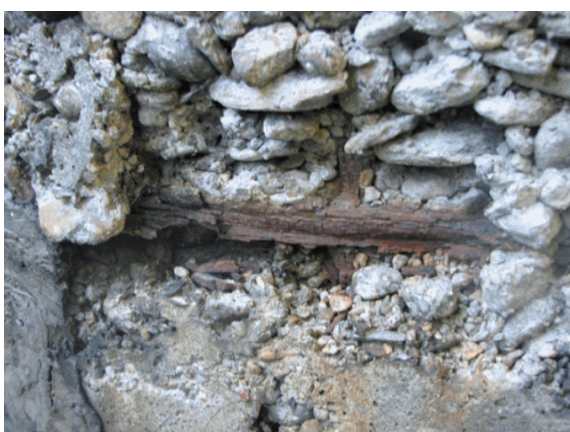
Foto 21: sui pilastri ove presente il distacco del copriferro si riscontrano armature corrose con la sezione resistente ridotta.
