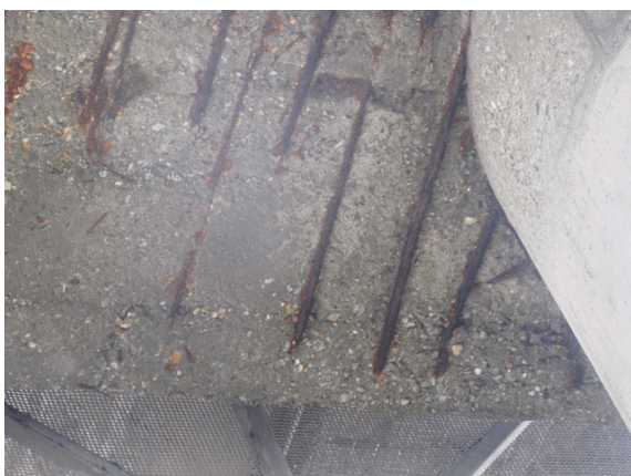
Foto 29: sui pulvini ove presente il distacco del copriferro si rilevano armature corrose e ridotte di sezione.
