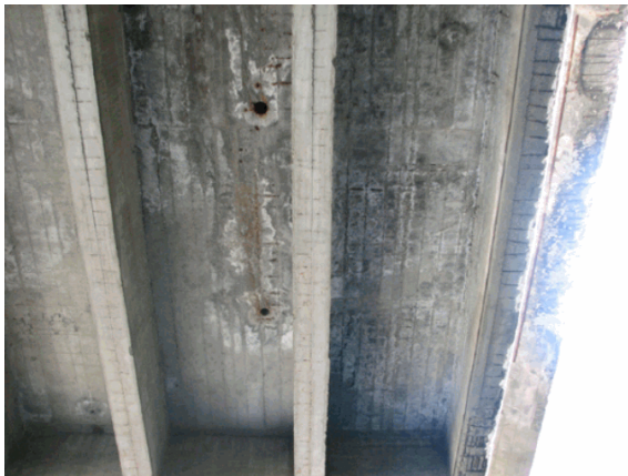
Foto 48: ovunque all'intradosso delle solette sono presenti macchie di umidità, in particolare verso i bordi e ove presenti gli scarichi.
