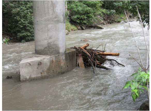
Foto 24: alla base della IV pila da monte si riscontra la presenza di detriti.
