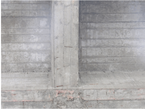
Foto 47: in alcuni punti all'intradosso dei traversi si rilevano staffe scoperte e ossidate.
