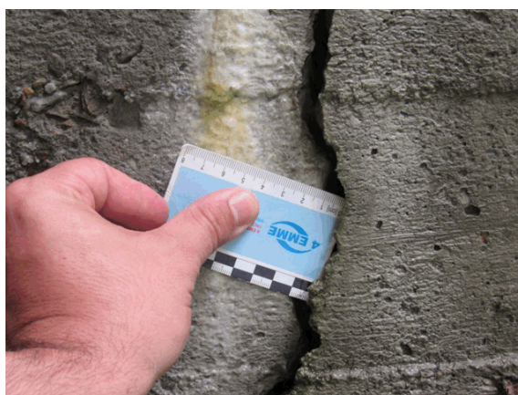
Foto 10: particolare dell'ampiezza massima rilevata pari a 1,1 mm in corrispondenza della fessura verticale a tutta altezza situata verso il bordo sinistro della spalla di monte.
