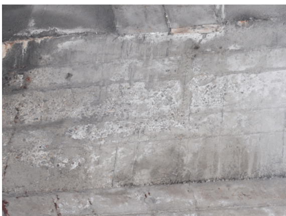
Foto 27: in poche zone dei pulvini si rileva la presenza di vespai di lieve entità.
