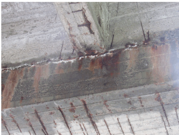
Foto 39: in alcune zone in corrispondenza degli appoggi delle travi sulle pile si rilevano dei danni causati dagli apparecchi d'appoggio, con un lieve degrado del calcestruzzo nella zona interessata.
