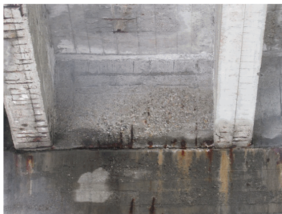
Foto 44: su buona parte dei traversi sono presenti dei vespai di tipo superficiale.
