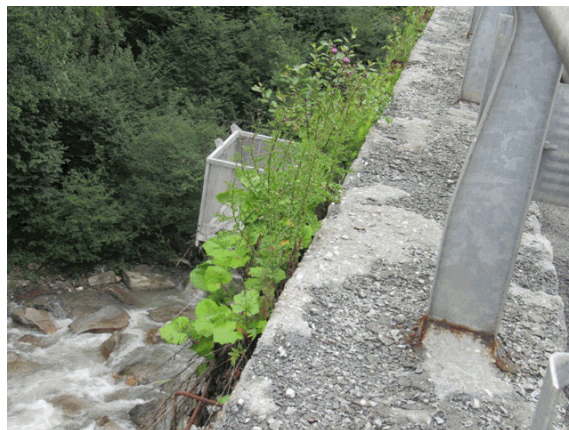
Foto 55: in corrispondenza del bordo sinistro della IV campata da monte ove si osservano notevoli porzioni di soletta distaccata si rileva la crescita di vegetazione.
