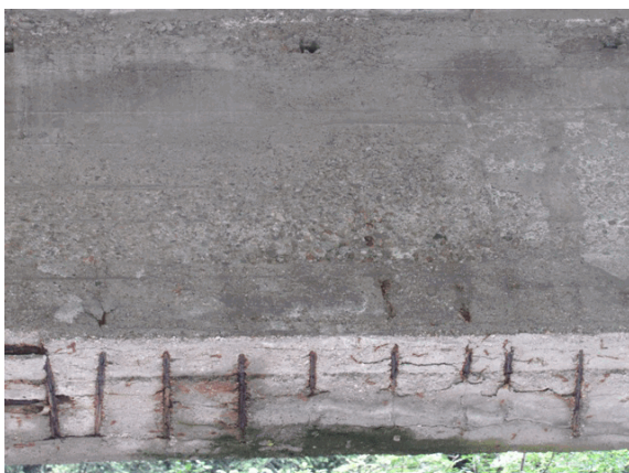
Foto 35: in poche zone sparse sulle travi, in particolare su quelle di bordo si rilevano dei vespai di lieve entità.
