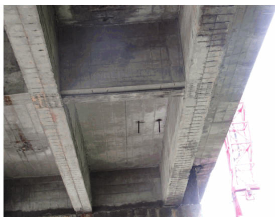
Foto 38: all'intradosso di tutte le travi si rilevano staffe scoperte e ossidate.
