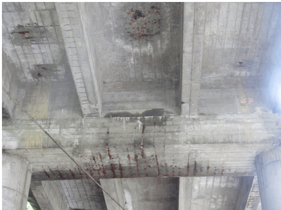
Foto 41: in ampie zone su tutti i traversi in modo particolare su quelli in corrispondenza dei giunti si riscontrano macchie di umidità.
