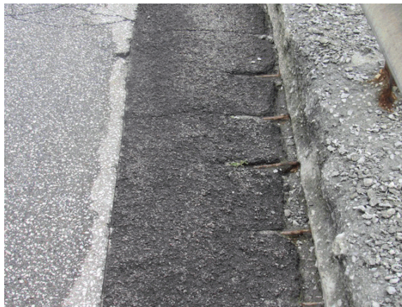
Foto 57: una fessura longitudinale corre in prossimità di entrambi i bordi della carreggiata per tutta la sua lunghezza, in queste zone si nota la presenza di armatura affiorante.
