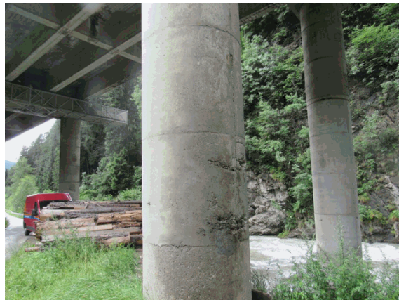
Foto 18: in alcune zone sparse, in particolare sulle facciate laterali dei pilastri esterni si nota il dilavamento del calcestruzzo.
