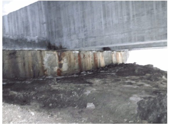
Foto 13: su tutta la superficie della spalla di valle si osserva il dilavamento del calcestruzzo.
