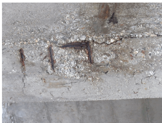
Foto 46: sui traversi ove presente il distacco del copriferro si rilevano armature corrose e ridotte di sezione.
