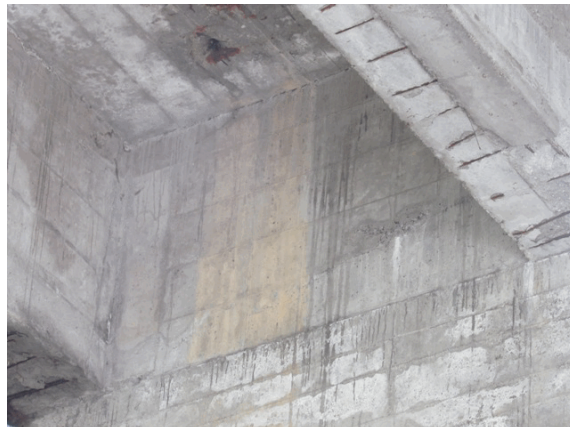
Foto 42: in diverse zone sui traversi in particolare su quelli posti sotto i giunti e in corrispondenza degli scarichi della soletta il calcestruzzo si presenta dilavato.
