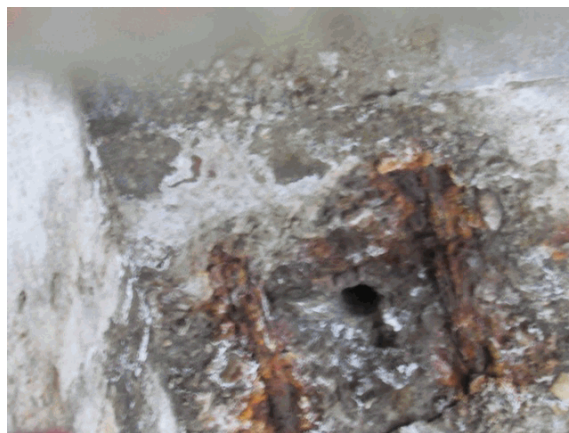
Foto 53: sulle solette ove presente il distacco del copriferro si notano armature corrose con sezione resistente ridotta.
