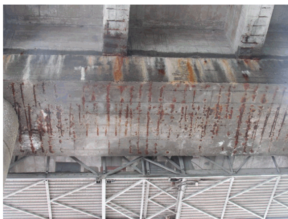
Foto 28: su tutta la superficie dei pulvini, in particolare all'intradosso si osserva il distacco del copriferro.
