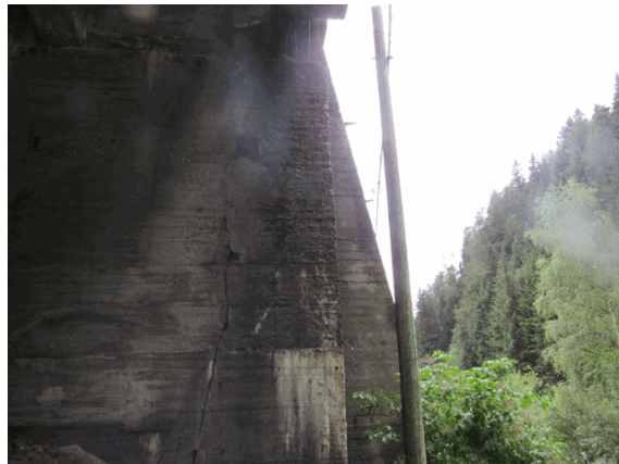
Foto 2: in diverse zone della spalla di monte, in particolare verso i bordi il calcestruzzo è completamente dilavato.
