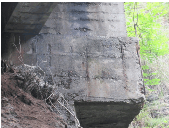
Foto 14: in varie zone sulla spalla di valle si nota il distacco del copriferro.
