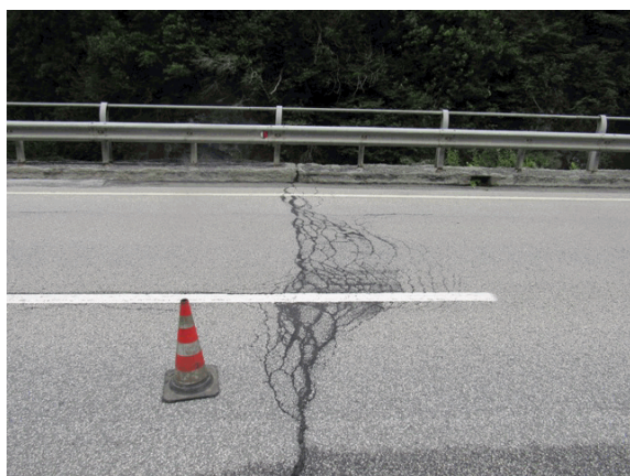
Foto 31: su tutti i giunti sottopavimentazione si nota la deformazione dei tamponi.
