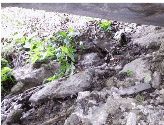
Foto 16: sul lato sinistro della spalla di valle si osserva il dissesto del rilevato.
