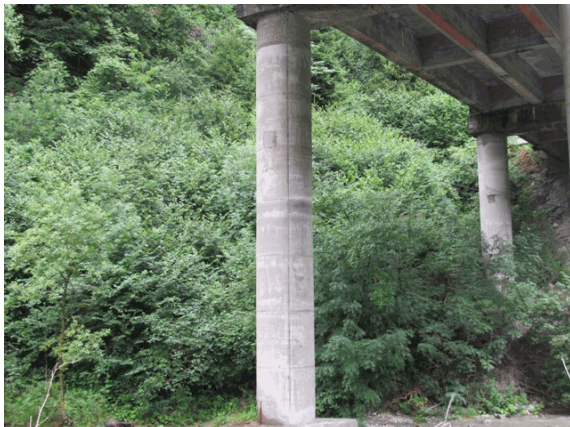
Foto 17: in varie zone su tutti i pilastri delle pile si rilevano macchie di umidità.
