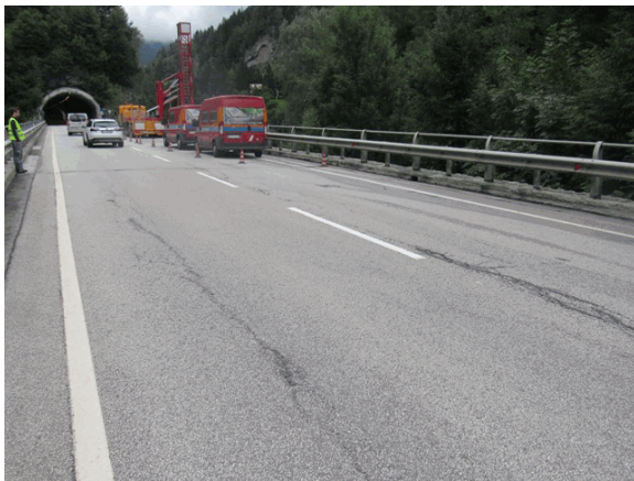
Foto 56: sulla pavimentazione si rilevano diverse fessure verticali e orizzontali.
