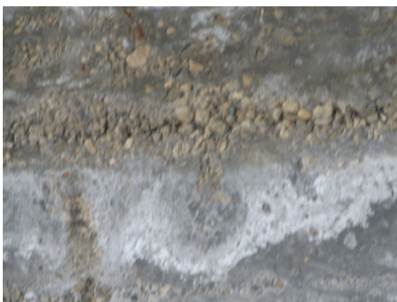
Foto 50: in alcuni punti intradossali delle solette sono visibili vespai con inerte in vista.
