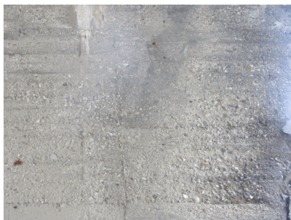
Foto 4: in qualche zona della spalla di monte soprattutto al centro e verso destra, sono presenti dei vespai con inerte in vista.
