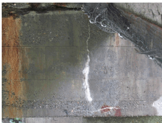
Foto 30: sulla facciata di valle del pulvino della III pila da monte è presente una fessura verticale capillare posta sotto la trave di bordo destro estesa dalla sommità fino a 10 cm dallo spigolo inferiore del pulvino.
