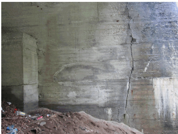
Foto 7: sulla spalla di monte a 1 m dalla base si osserva una fessura orizzontale estesa per tutta la larghezza con ampiezza massima pari a 2,5 mm.
