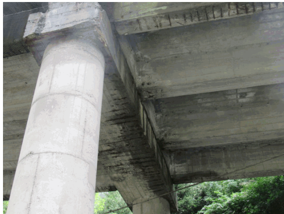
Foto 26: in ampie zone dei pulvini si osserva il dilavamento del calcestruzzo per fuoriuscita di acqua dalla zona dei giunti.
