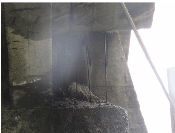
Foto 43: i traversi posti sotto i giunti risultano ammalorati in diverse zone, in particolare una porzione del I traverso da monte a sinistra risulta completamente mancante.
