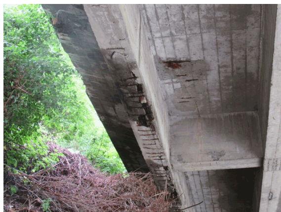
Foto 36: in ampie zone sulle travi, in particolare su quelle di bordo si rileva il distacco del copriferro con pericolo di caduta di porzioni di calcestruzzo sulla strada sottostante, il fenomeno è meno marcato sulle travi centrali.
