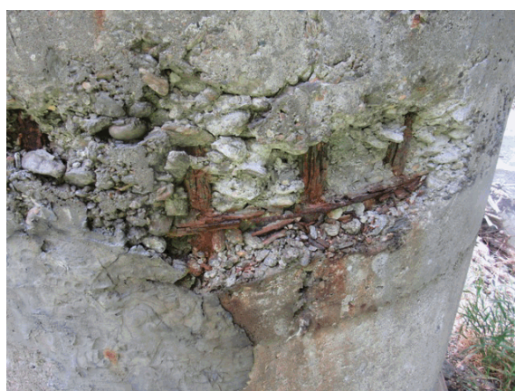
Foto 22: sui pilastri delle pile ove presente il distacco del copriferro si rileva la corrosione delle staffe con riduzione della sezione resistente, nel dettaglio il pilastro destro della III pila da monte dove alcuni elementi sono rotti.
