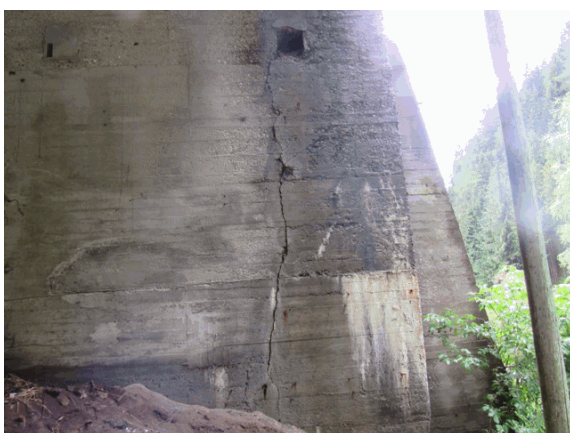
Foto 9: a 1,5 m dallo spigolo sinistro della spalla di monte è presente una fessura verticale a tutta altezza con ampiezza massima di 1,1 mm e un lieve spanciamiento della porzione verso la pila.
