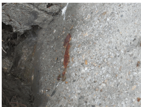
Foto 6: sulla spalla di monte ove presente il distacco del copriferro si rileva l'ossidazione delle armature affioranti.
