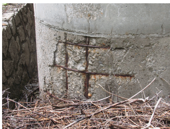
Foto 20: in qualche zona alla base e più raramente in sommità di tutti pilastri delle pile il copriferro risulta distaccato.
