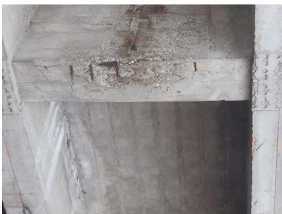
Foto 45: nella parte inferiore e all'intradosso dei traversi in particolare su quelli posti su spalle e pile il copriferro risulta distaccato.
