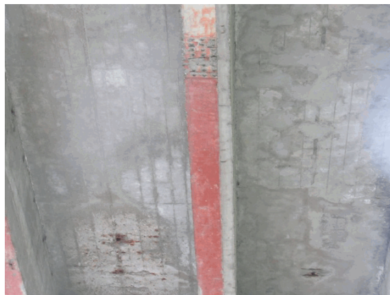
Foto 40: all'intradosso delle travi della IV, V e VI campata da monte si rileva un dislivello.
