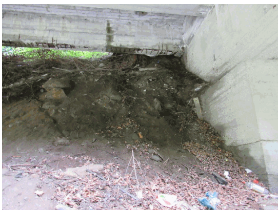
Foto 11: sul lato destro della spalla di monte si osserva il dissesto del rilevato.
