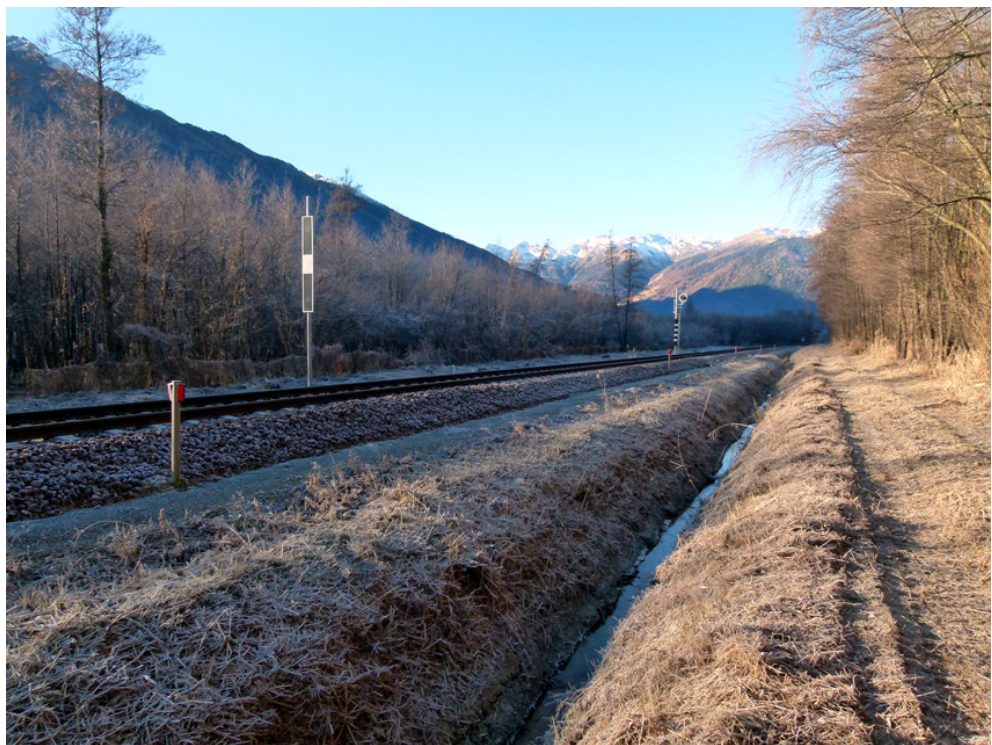
Fig. 3: canale a fianco della massicciata ferroviaria
