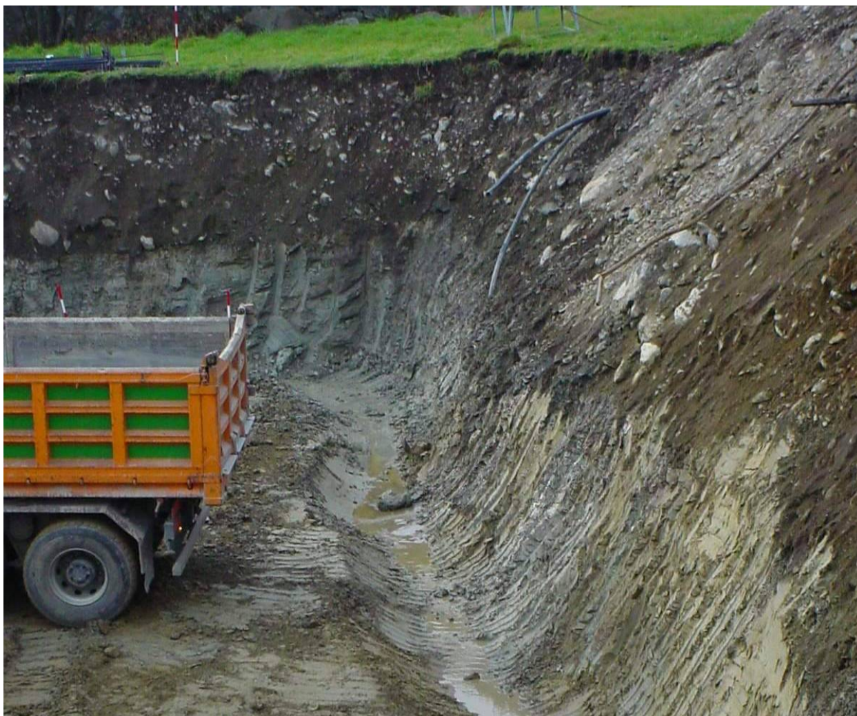
Foto 11: Assetto tipico del terreno nella parte media del tracciato: sopra detrito di debris flow a granulometria mista, sotto sedimenti lacustri fini; (foto dello scavo per il nuovo capannone VVFF)
