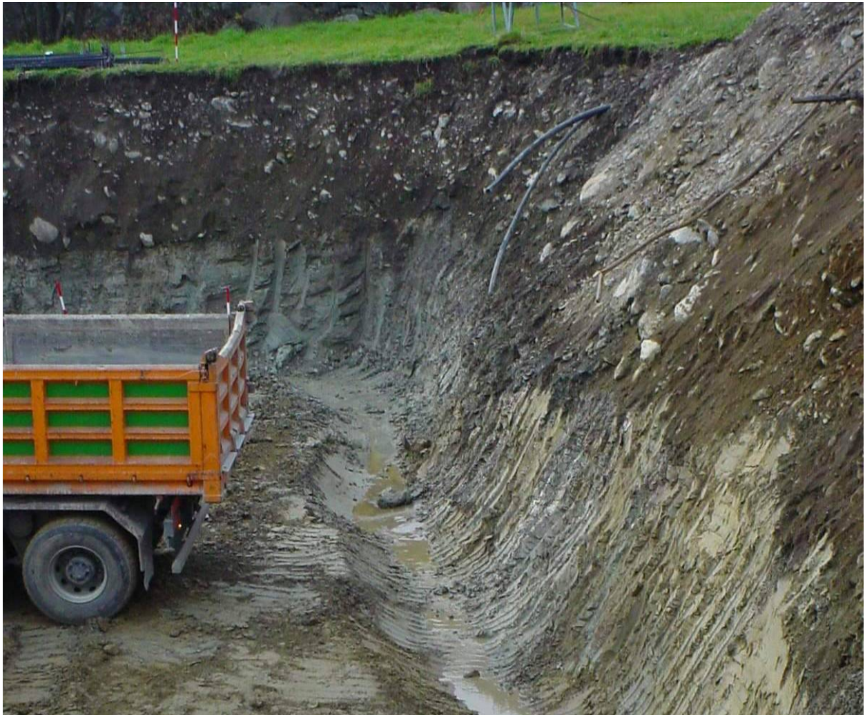
Foto 11: Typischer Bodenaufbau im mittleren Trassenabschnitt: oben gemischtkörniger Murschutt, unten feinkörnige Seesedimente; (Aufnahme vom Aushub für die neue Feuerwehrrhalle in Vahrn).
