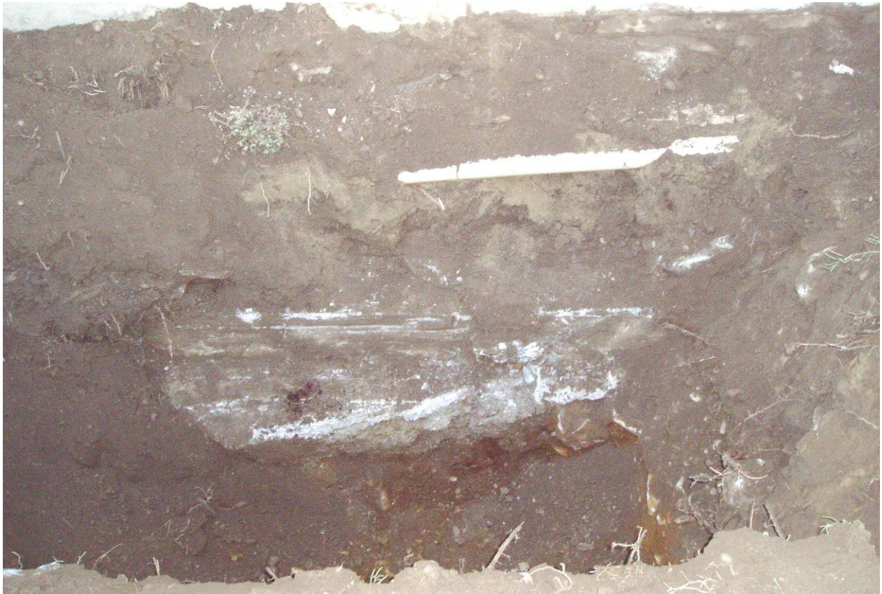
Foto 5: Erkundungsschurf SCH3: Gründungsverhältnisse bei westlicher Schwergewichtsmauer der Autobahn oberhalb Volksbankgebäude.
