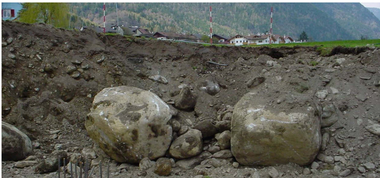
Foto 12: Dettaglio dallo scavo del capannone VVFF: detrito di debris flow con blocchi granitici arrotondati di oltre 1,5 m (foto messe a disposizione dalla ditta esecutrice).
