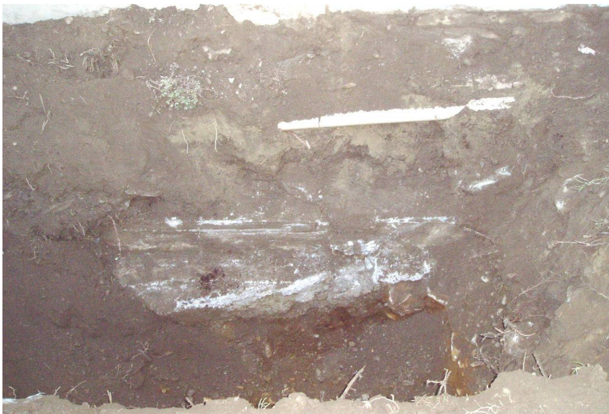
Foto 5: Scavo d'ispezione SCH3: situazione delle fondazioni del muro di sostegno occidentale dell'autostrada sopra l'edificio della Banca Popolare
