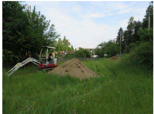
Foto 3+4: lokaler Baggerschurf, der bis auf den Fels ausgeführt wurde Scavo geognostico locale, eseguito sino al raggiungimento del substrato roccioso
