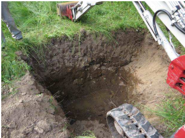
Foto 3+4: lokaler Baggerschurf, der bis auf den Fels ausgeführt wurde Scavo geognostico locale, eseguito sino al raggiungimento del substrato roccioso
