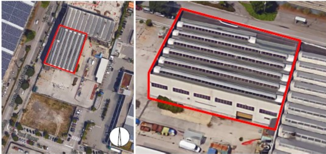
Figura4 – (sinistra) ortofoto e (destra) fotografia a volo d’uccello del capannone che diventerà la futura sede del laboratorio di Ingegneria Agroforestale. Come è possibile vedere, esso è parte di un edificio più grande, avente una superficie coperta complessiva di circa 2700 m 2 .
