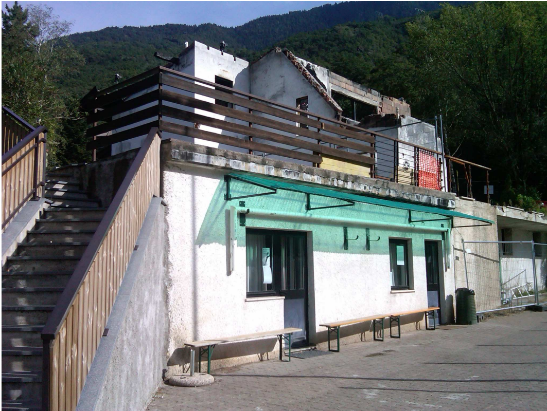
Ansicht Bestand von Südwest unteres Niveau – Prospetto edificio esistente da sudovest piano inferiore
