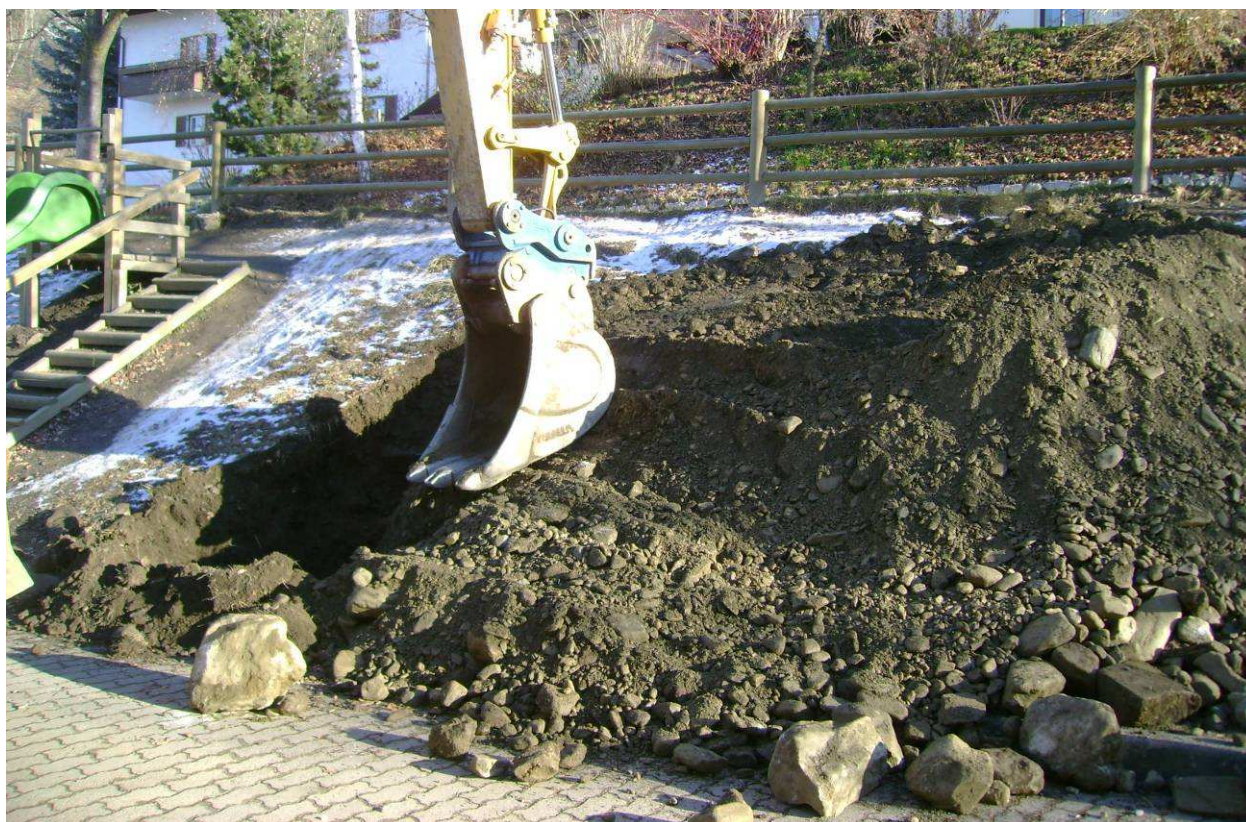
Foto 2: Ansicht Richtung NE der Böschung östlich und hangseitig der geplanten Erweiterung, Schurf T2; oben der Straßenrand mit Grenzzaun / vista verso NE della scarpata ad est e sul lato monte dell'ampliamento previsto, scavo T2; in alto il bordo stradale con la rispettiva recinzione.
