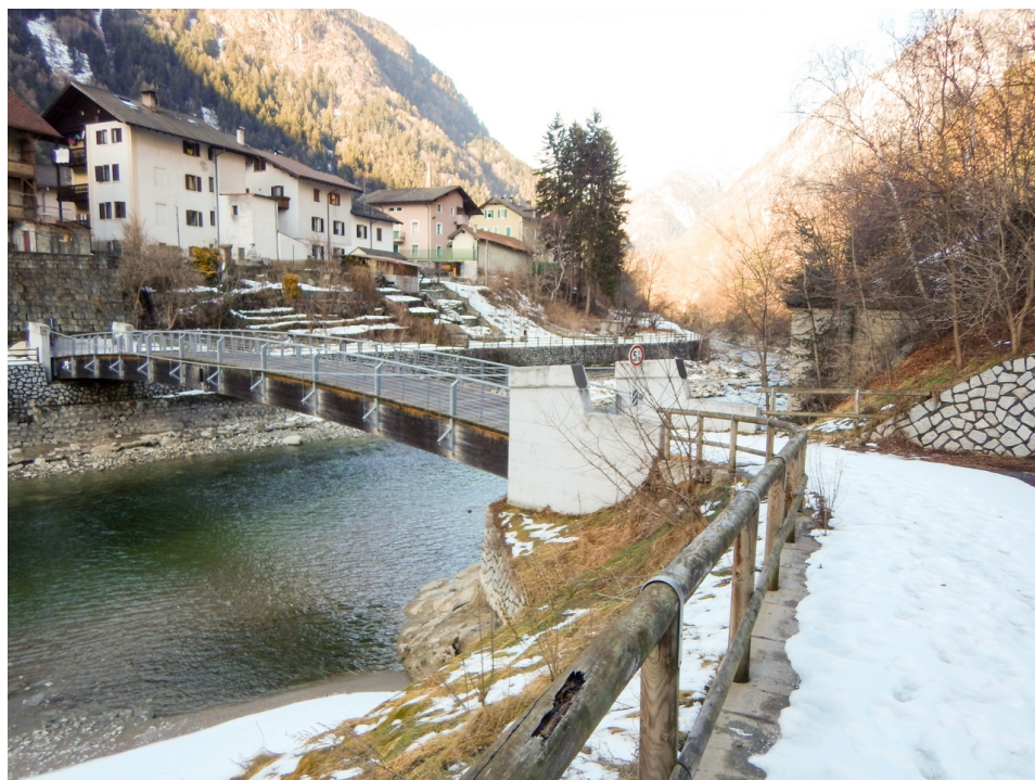
(a) Ponte ciclopedonale che attraversa il fiume Isarco in corrispondenza dell'inizio del lago
