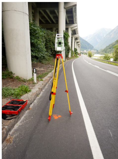
(b) Stazione topografica lungo la S.S.12 sotto il cavalcavia autostradale
