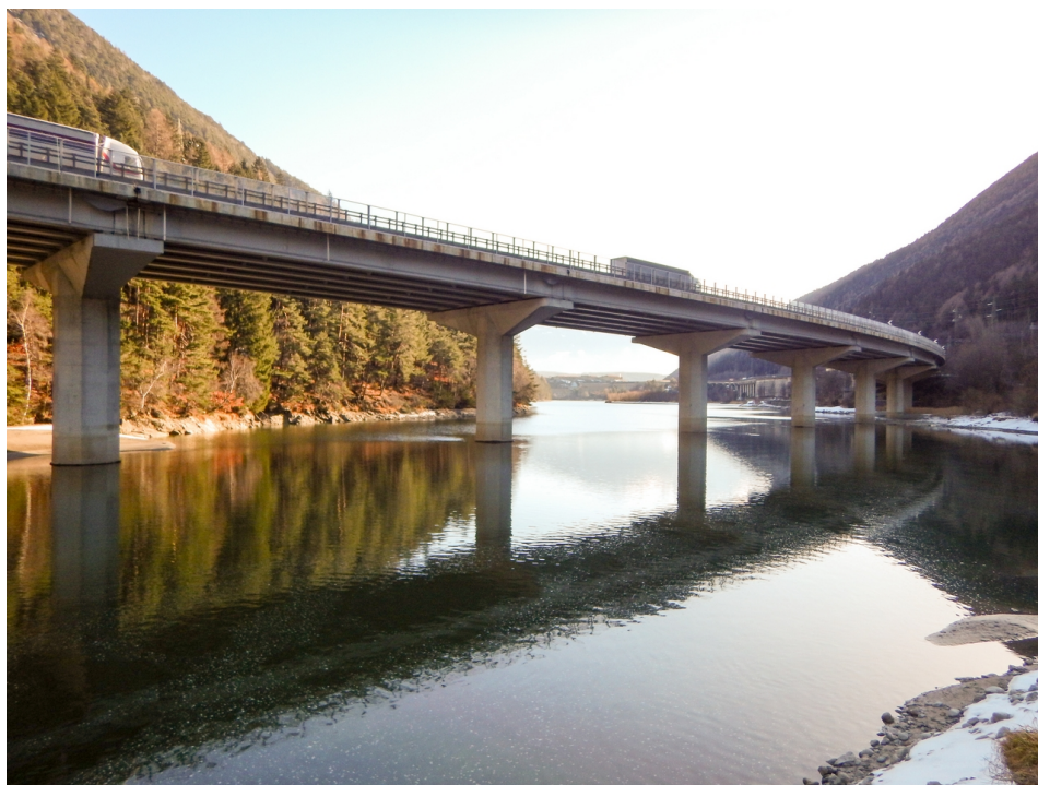
(c) Pile del viadotto autostradale vista da nord verso sud dalla stazione nella foto 1.5 b)
