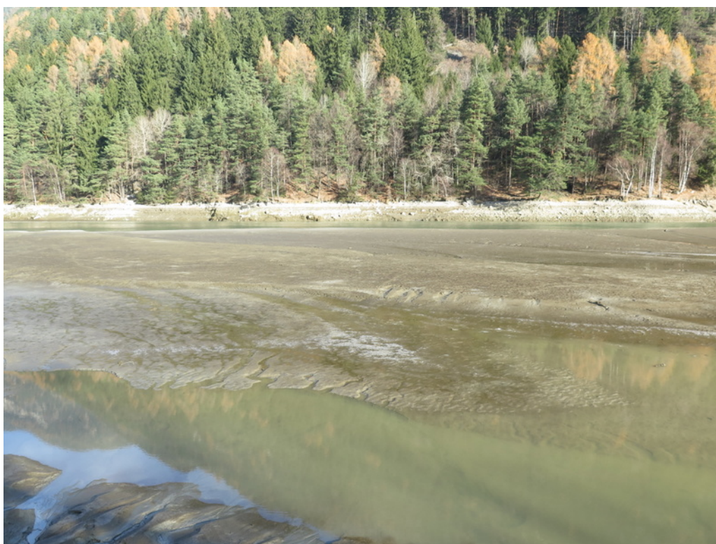
Figura 1.1: Area di studio: (alto) planimetria dell'area; (basso) penisola sabbiosa lungo la sponda destra del lago, dove sorgerà una pila della passerella pedo-ciclabile
