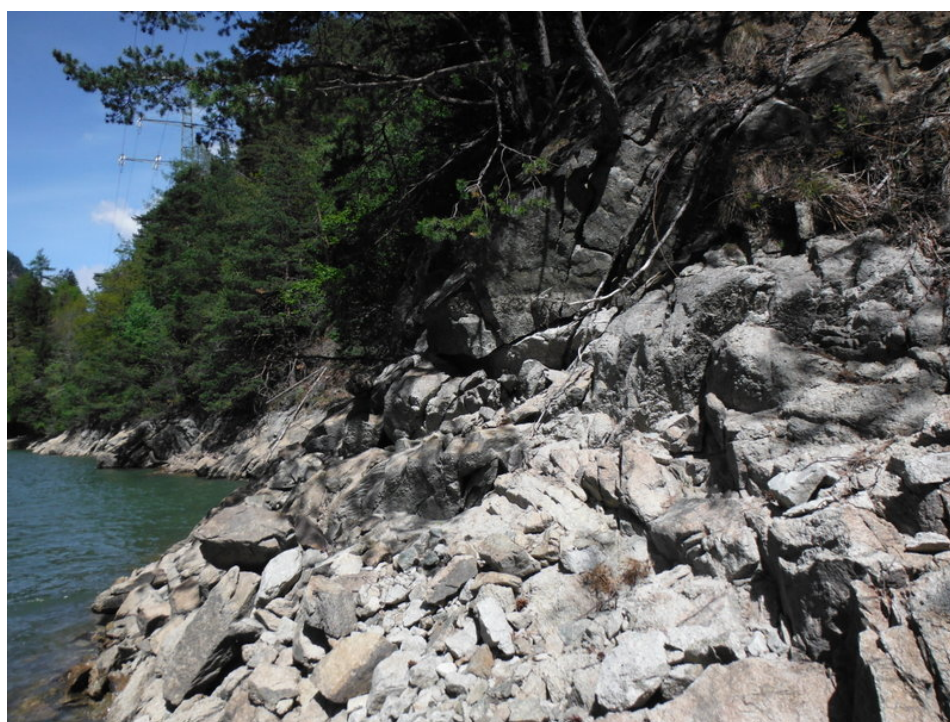
(b) Zona individuata per la spalla del ponte lungo la sponda destra del lago
