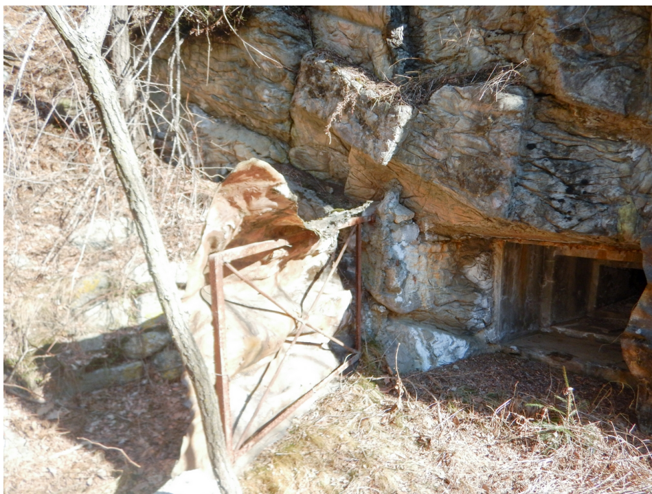
(a) Particolare feritoie bunker sul versante in sinistra lago
