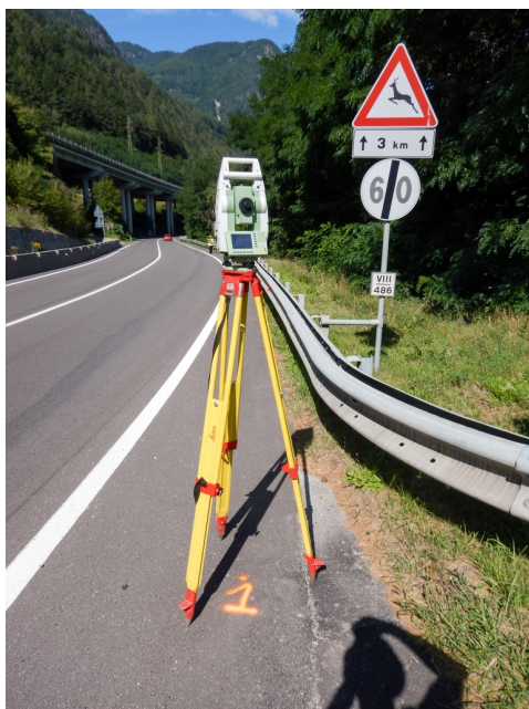
(a) Prima stazione del rilievo posizionata all'imbocco del Forte di Fortezza sulla S.S.12
