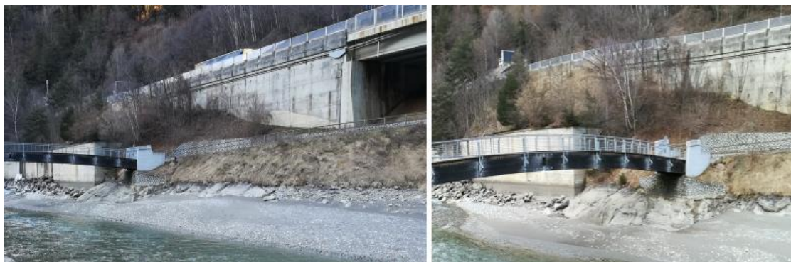
Foto 37: La spalla del ponte in sinistra idraulica all'Isarco; sono visibili l'affioramento di Granito di Bressanone, i depositi fluviali di origine mista, i muri di sostegno e il detrito di versante (a valle e a monte della ciclabile).
