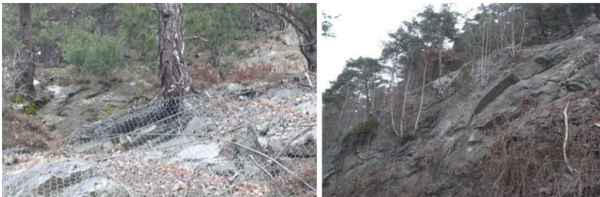
Foto 55: La rete in aderenza ad est del rio K.6. Sulla sinistra un dettaglio della sua parte superiore, sulla destra una vista generale.
