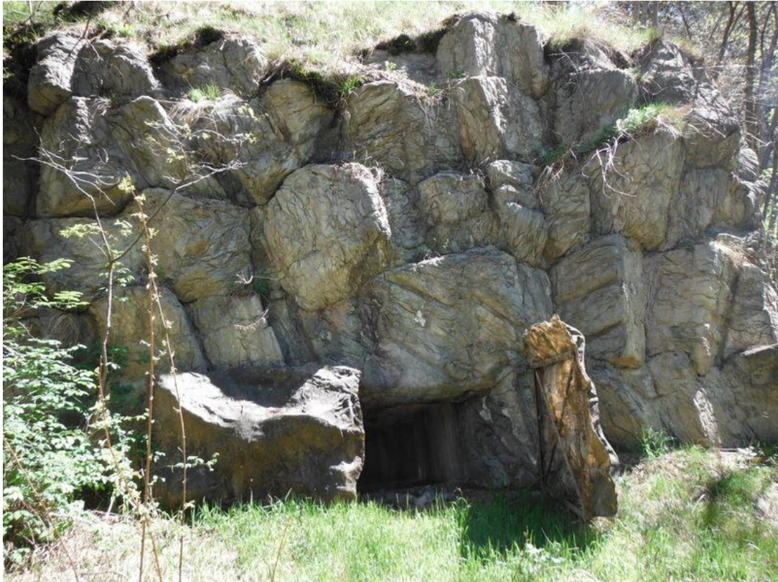
Foto 4: L'aspetto esterno di una feritoia del bunker n°1. Si notino le soluzioni costruttive adottate a favore del mimetismo con ambiente e ammasso roccioso circostante.
