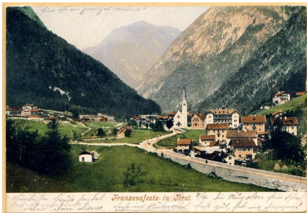
Figura 3: La strada antecedente all'istituzione della SS12 all'accesso sud dell'abitato di Fortezza in una cartolina antecedente il 1918 (da www.fortezzaopenarchive.net ).
