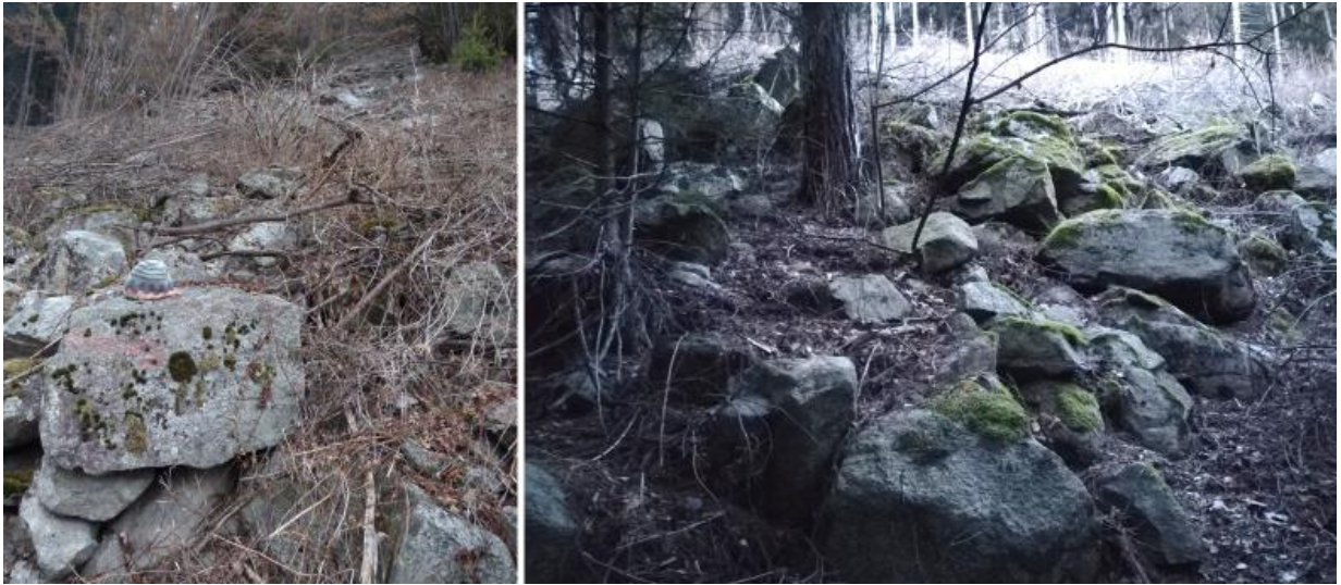
Foto 50: Il deposito a grossi blocchi ad est del rio K.1. Sulla sinistra fotografato nella zona del sentiero di monte, sulla destra nel bosco tra pista ciclabile e il sentiero.
