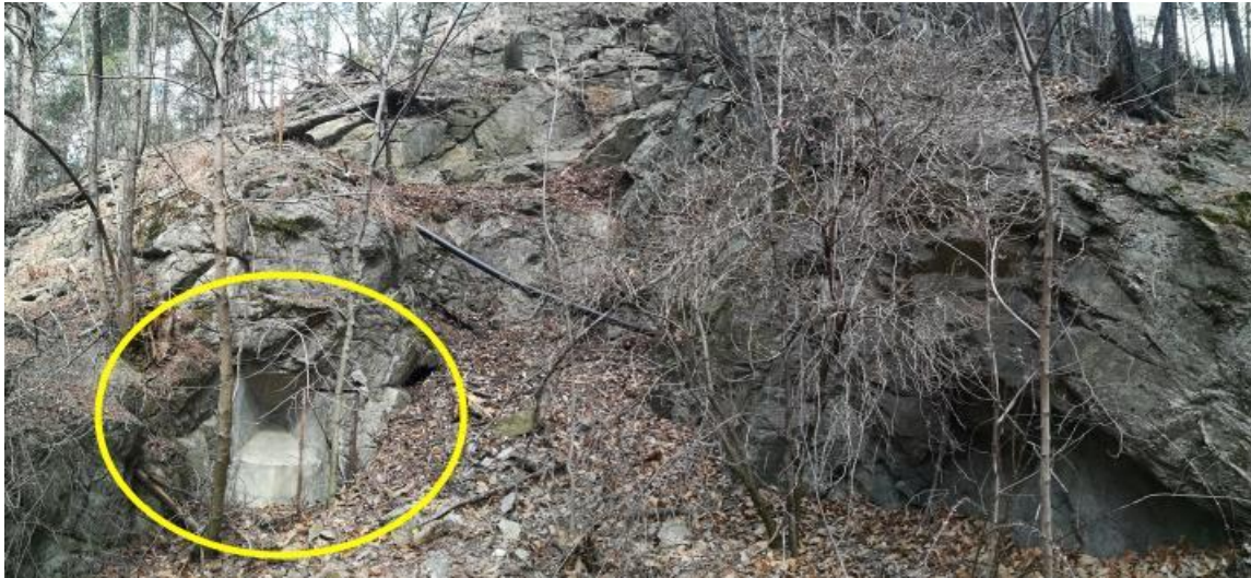
Foto 56: Una feritoia (evidenziata in giallo) del bunker n°1 per la cui realizzazione è stato effettuato lo sbancamento che ha messo a luce un'area soggetta a crolli e ribaltamenti ( \varnothing = 0,5 \div 2 m).
