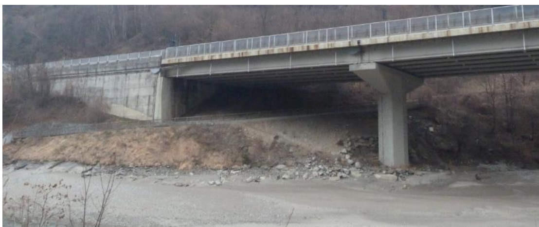
Foto 43: La pista ciclabile nel tratto del sottoattraversamento del viadotto autostradale. Sono visibili il grande muro di sostegno dell'A22, quello più piccolo che borda la ciclabile e la scogliera in massi ciclopici retrostante il primo pilone del viadotto.
