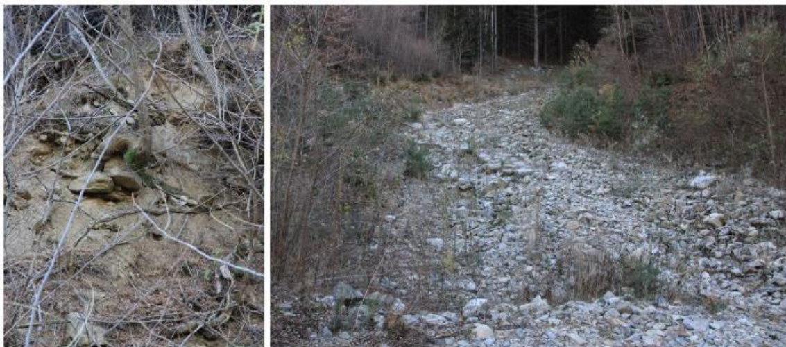
Foto 26: La porzione del conoide del Rio della Chiusa a monte della ferrovia. Sulla destra l'attuale canale sul quale scorre il rio; sulla sinistra un dettaglio della scarpata antropica prodotta dallo sbancamento che mette in luce la natura del deposito.
