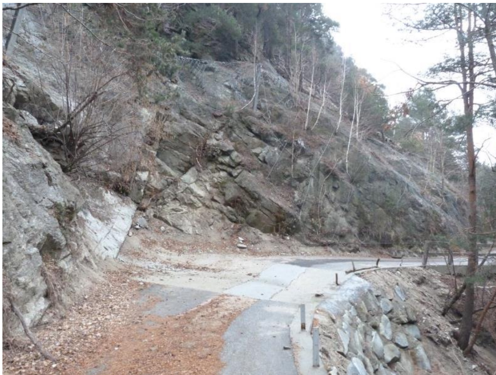
Foto 17: Scogliera cementata a valle della pista ciclabile, in corrispondenza del rio K.6. che si presentava asciutto. Si noti anche la presenza della barriera paramassi/debris flow a monte.
