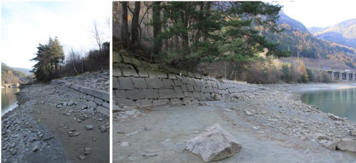
Foto 32: I muri di sostegno dei terrapieni delle pertinenze del forte asburgico, parzialmente ricoperti dal deposito antropico e dalle attuali deposizioni riconducibili alle acque del lago.
