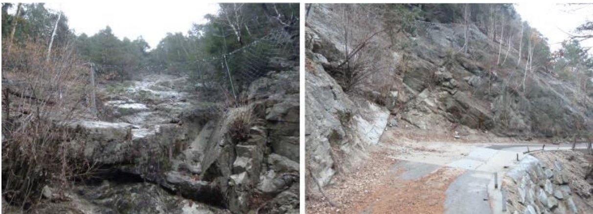
Foto 54: La barriera paramassi (sulla sinistra) e la scogliera (destra) in corrispondenza dell'attraversamento del rio effimero K.6.
