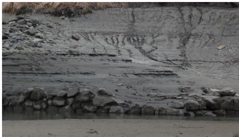
Foto 21: I resti del muro a secco che sosteneva l'antico tracciato della statale, antecedente all'invaso, visibile sotto il viadotto dell'A22, nei pressi del conoide del Rio Salceto.
