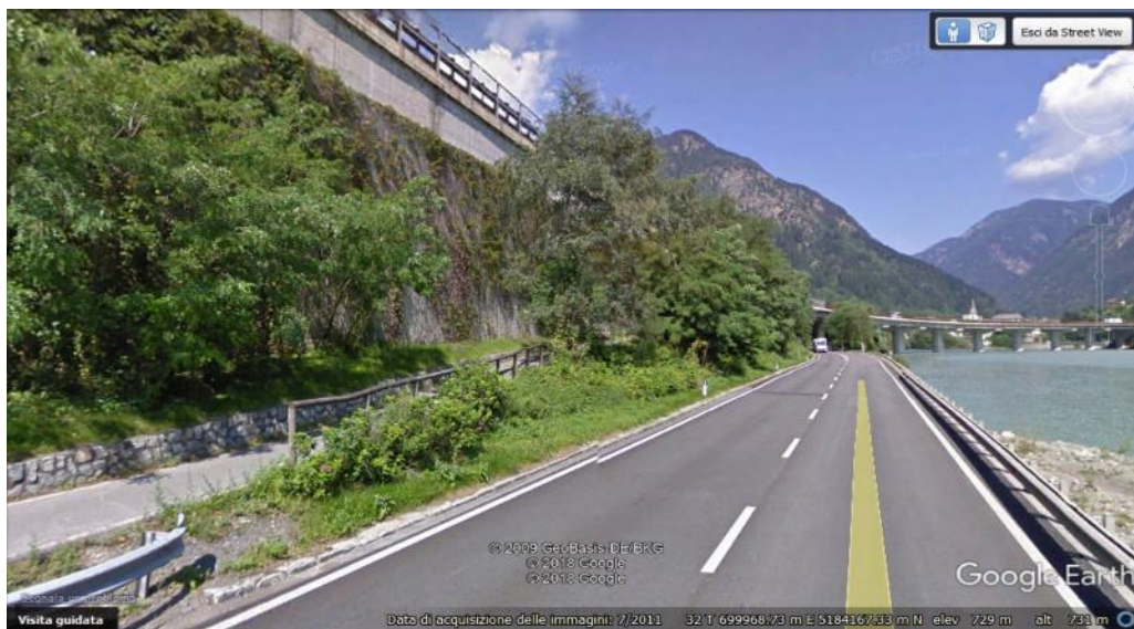
Figura 6: Il tratto di SS12 che corre al piede dell'imponente muro di sostegno dell'A22. Tra il muro e la statale corre la pista ciclabile, bordata da aiuole in terreno di riporto (da Google Earth Street View)
