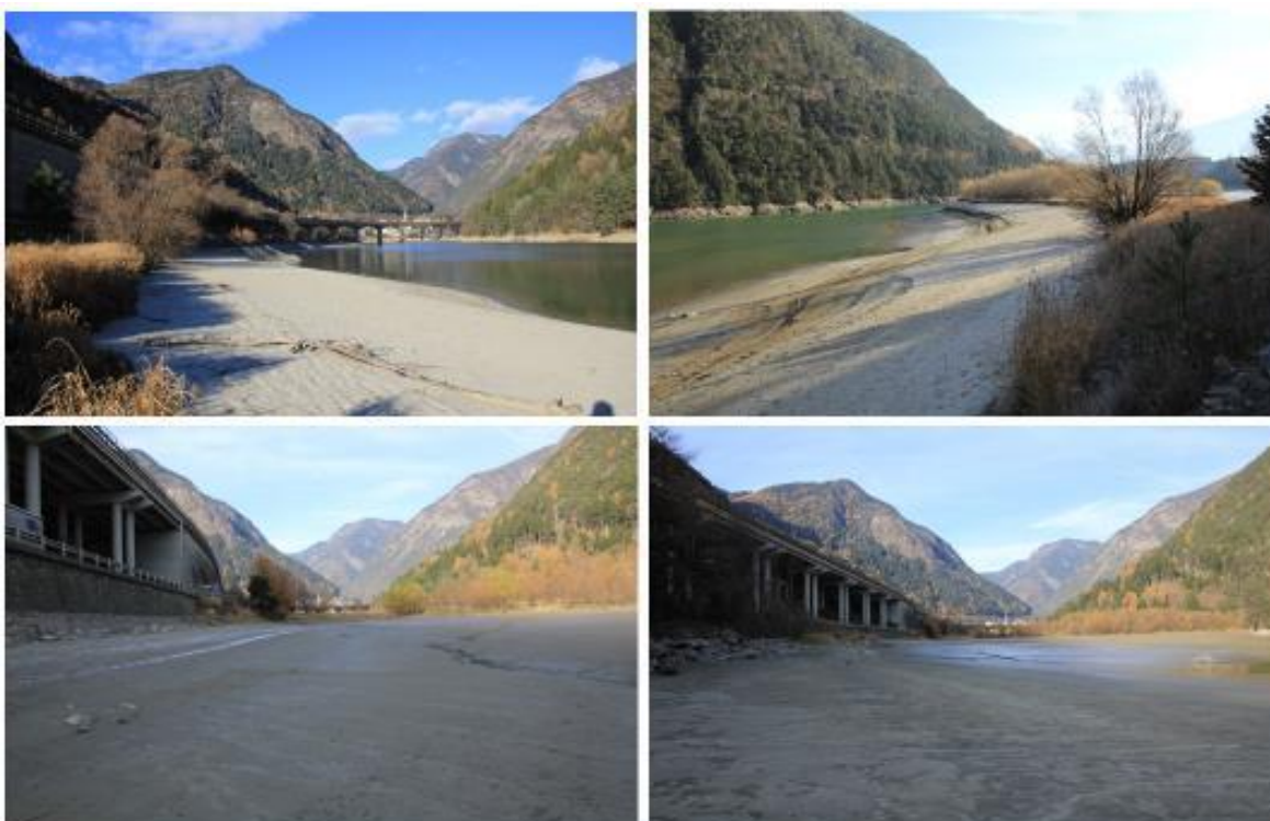
Foto 34: Limo e sabbia ricoprono i terreni della penisola (foto a destra in alto) fino al conoide del Rio della Chiusa (sinistra in alto) e si estendono verso sud est a valle del muro di contenimento della SS12 (in basso a sinistra) sino alla zona di uscita del rio B.430 da dove è stata scattata la foto in basso a destra.
