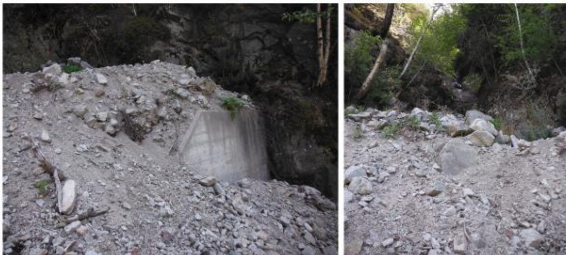
Foto 16: La briglia del rio B.7 come si presentava a maggio 2017; gli eventi pregressi avevano completamente ricoperto l'opera, ostruendo anche parte della pista ciclabile.
