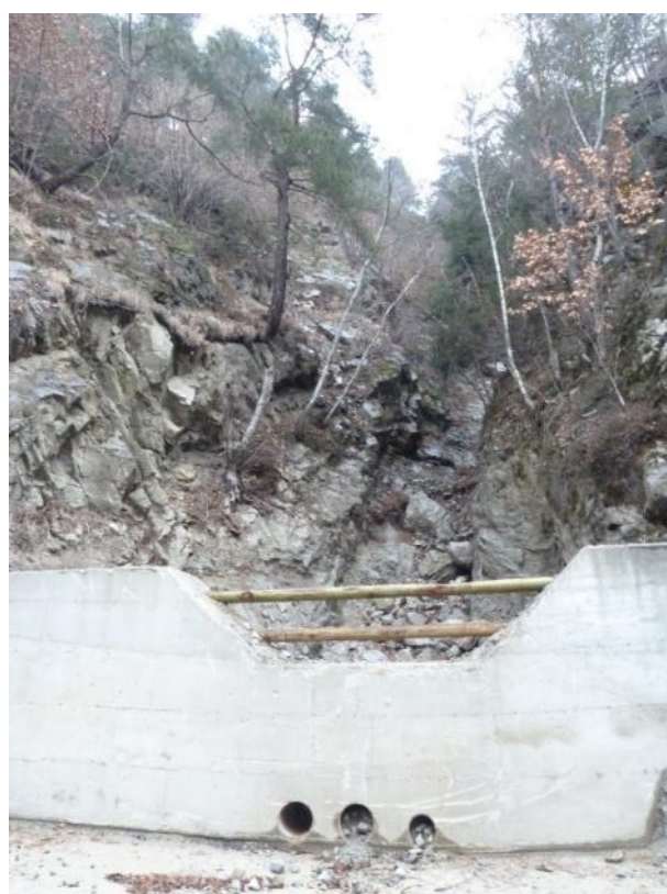
Foto 61: Il rio B.7 completamente asciutto e la relativa briglia, svuotata dal detrito che a maggio 2017 la ricopriva totalmente.
