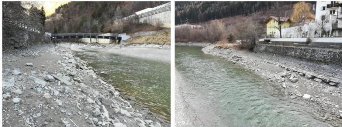
Foto 19: depositi fluviali di origine mista fotografati visti dalle vicinanze del piazzale asfaltato (foto di sinistra) e dal ponte (foto di destra). Si noti la scogliera cementata a contatto con il muro di sostegno.
