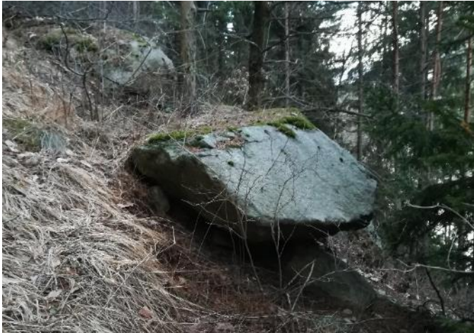
Foto 48: Blocco mobilizzabile con evidenza di scalzamento al piede.
